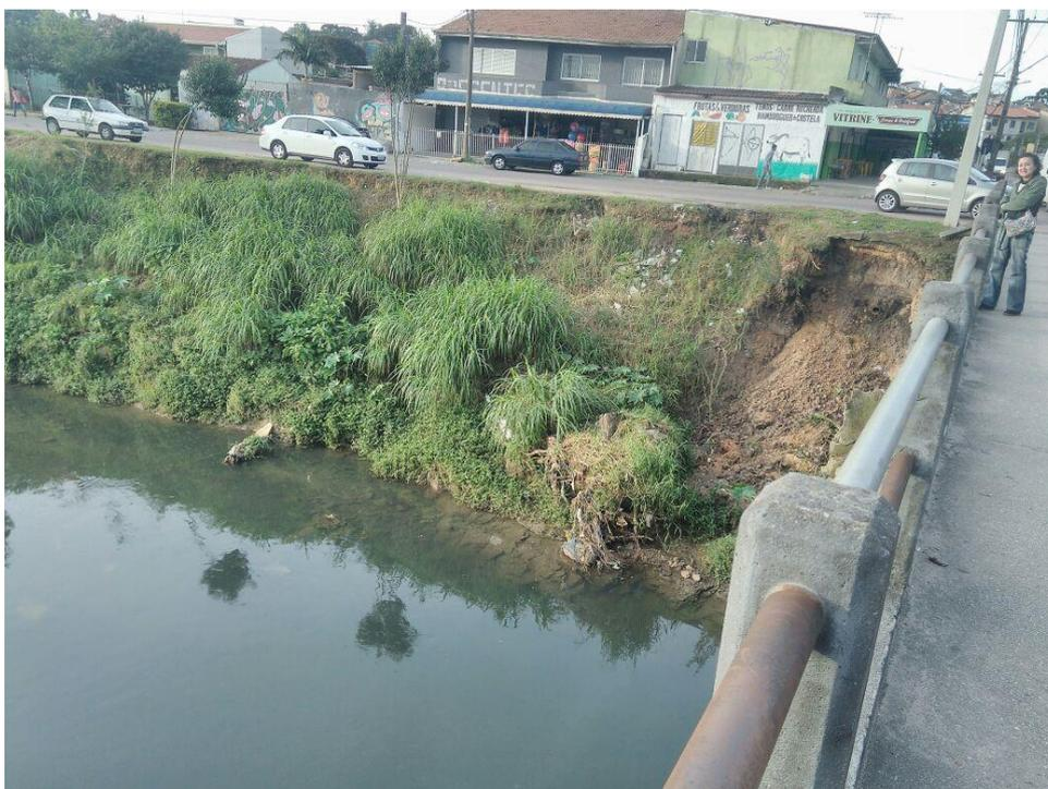
Figura 13: Área com erosão próxima a ponte sobre o rio Belém.
