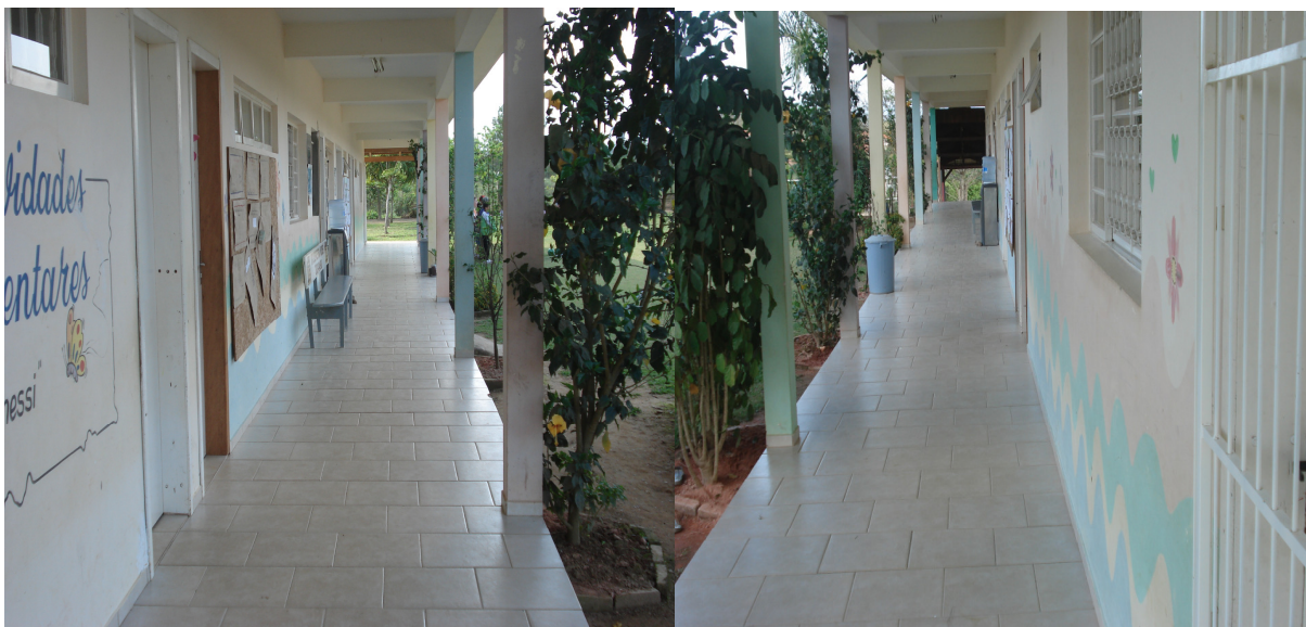
FOTO 09 – Corredor da sala – PERMITIDO FOTO 10 – Corredor da sala – PERMITIDO
